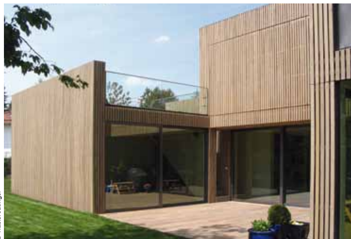
Offene Lamellenschalung DuraPatina, vorvergraut, stark wasserabweisend.
