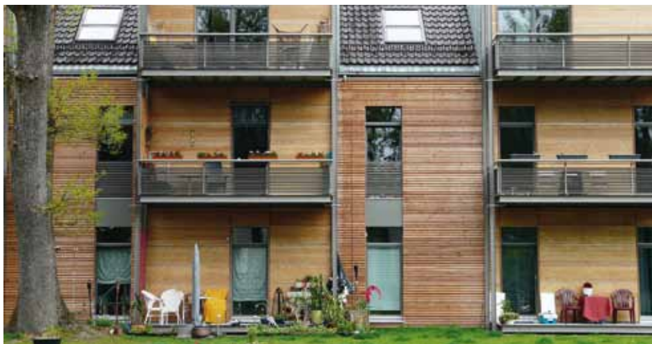
Mit geschosshohen, vorgefertigten Holzelementen sanierte Fassade in der ‚Stadt aus Holz‘, Bad Aibling. Im Balkonbereich ist die Fassadenhaut aus Brettspertholz sichtbar, daneben wurde das Brettspertholz mit horizontal aufgesetzten Lärchenleisten versehen.
