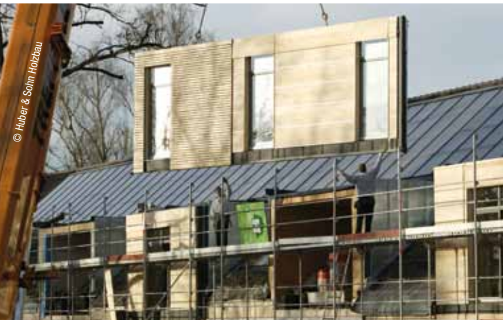
Montage komplett vorgefertigter Fassadenelemente.
